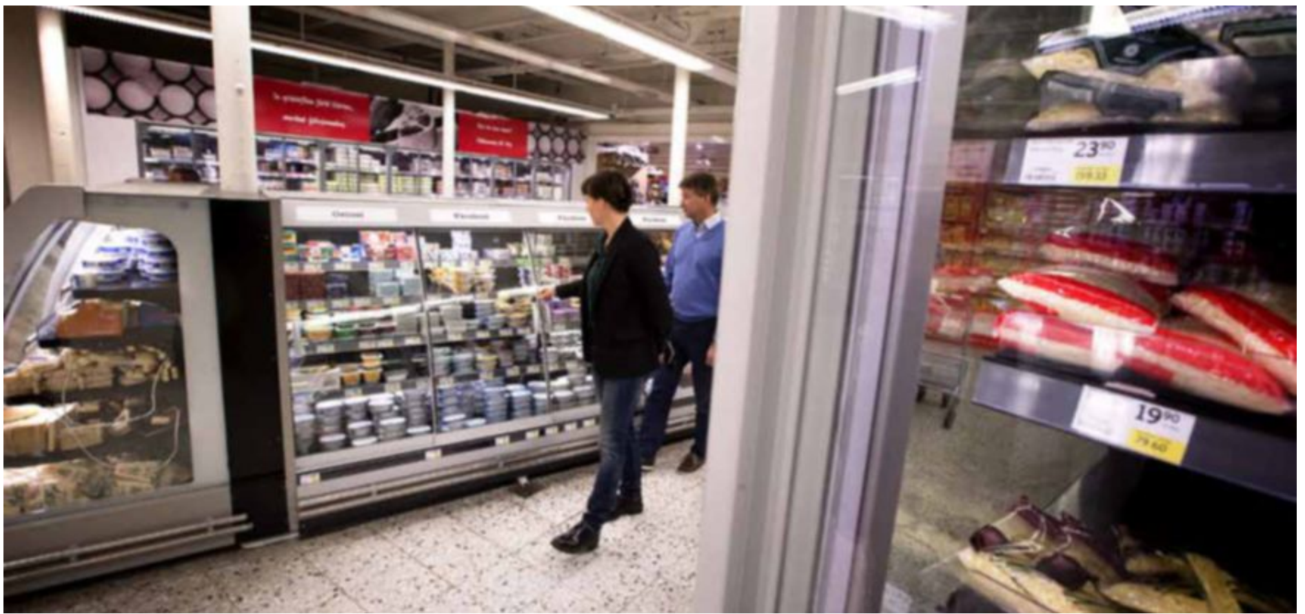
Alla kyldiskar på City Knalleland har försetts med dörrar. Det håller kylan på plats och minskar energiåtgången, konstaterar Ulla Lindberg och Håkan Ahlin.
